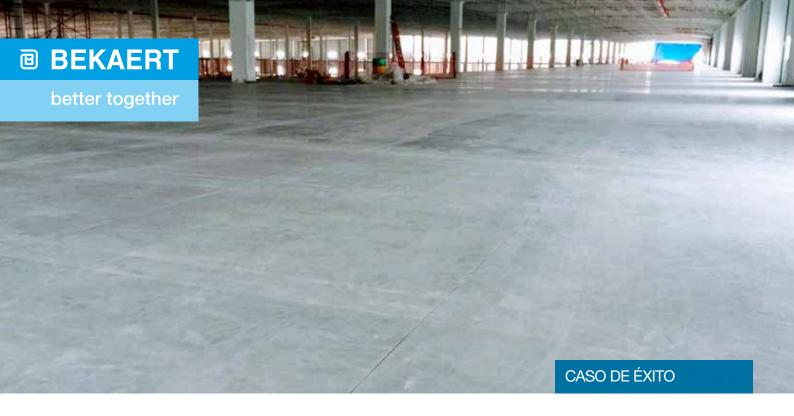
La solución para el control de fisuras basada en el empleo de fibras Dramix® fue instalada en el piso de 9,500 m² de la fábrica de Plexus en Zapopan. El resultado ha sido una gran superficie de calidad excepcional con fisuras mínimas.
